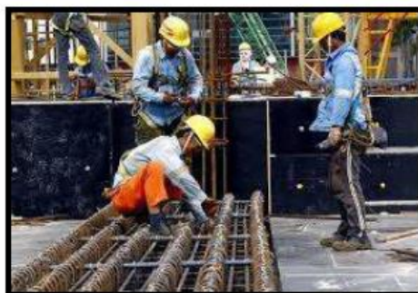
Gambar 2 : Pekerja binaan sedang bekerja
